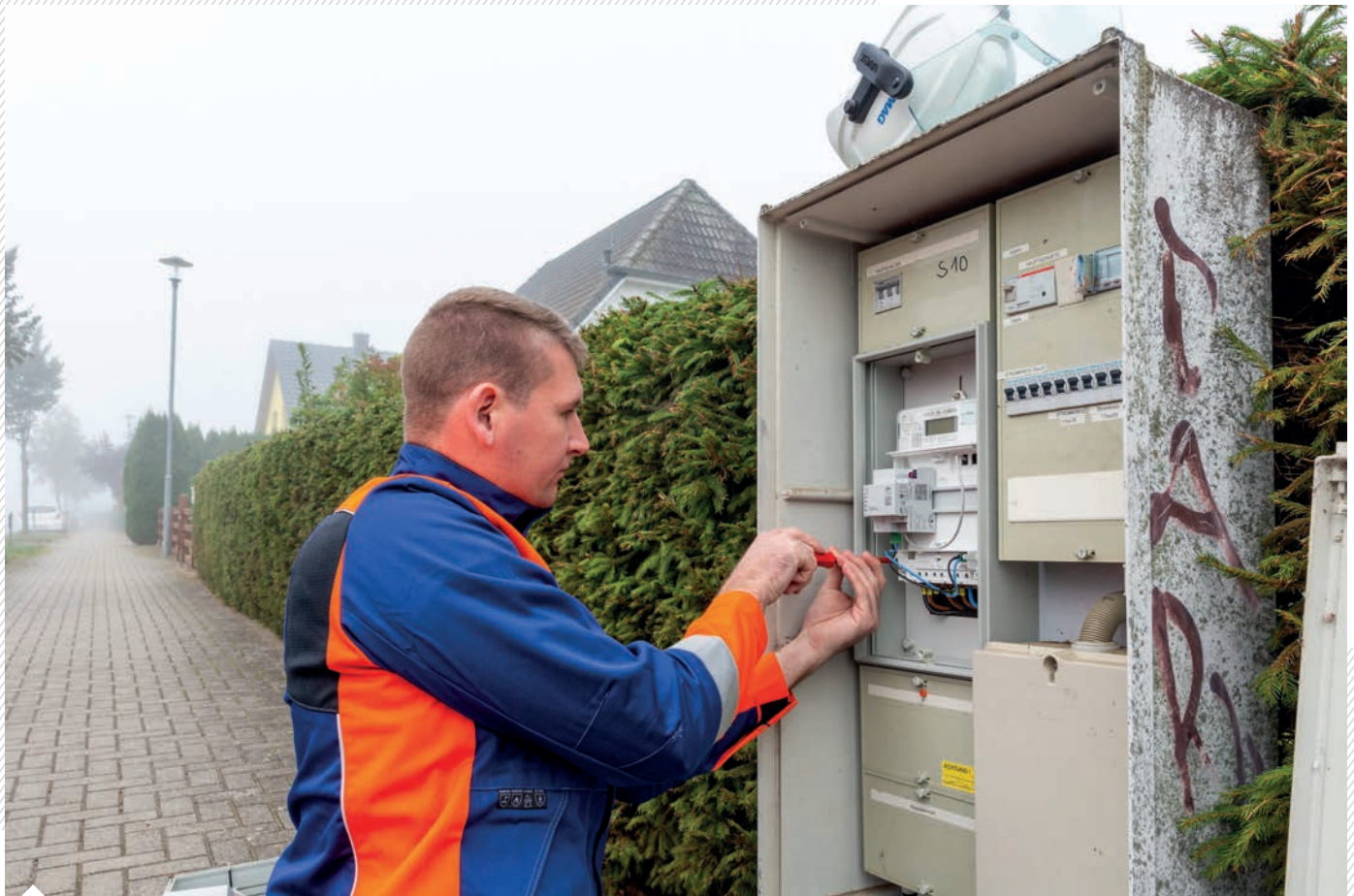
Im Auftrag der WEMAG Netz GmbH installiert ein Monteur der e.dat GmbH ein intelligentes Messsystem.
