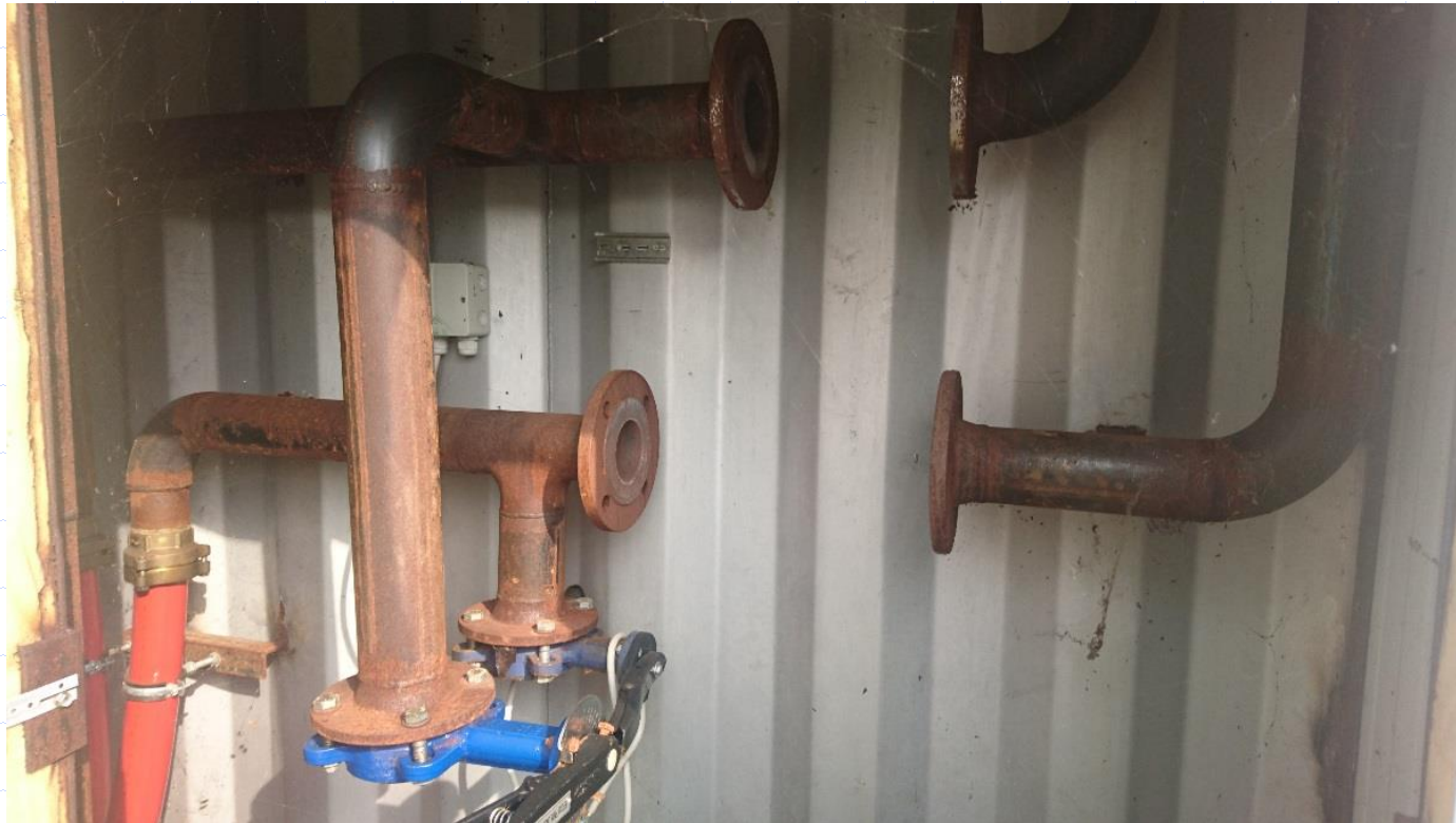
Demontierte WMZ Zwecks Anpassung der Arbeitswerte an (nicht vorhandenen) Trockner
