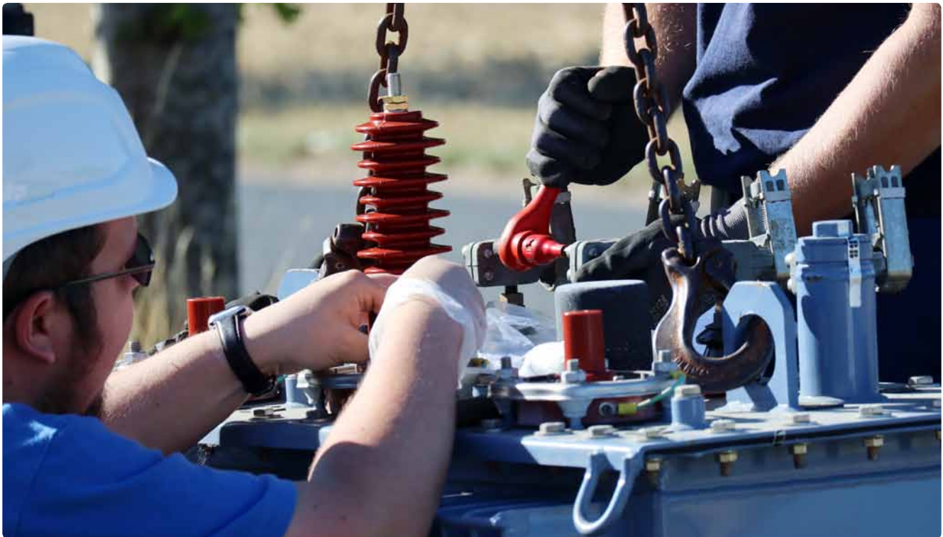
Spannender Schulterblick beim Tausch des Transformators an einem Mittelspannungsmast bei Schossin
