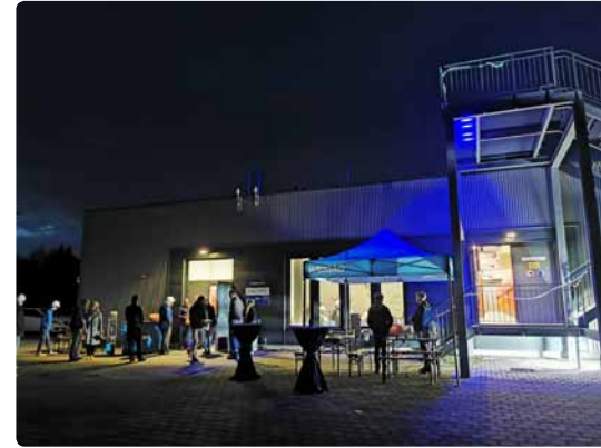
Großer Ansturm auf den Batteriespeicher in Schwerin herrschte auch in der Nacht des Wissens.
