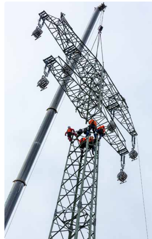
Hochspannungsleitung verschwindet aus dem Stadtbild: WEMAG Netz GmbH führt rund 3,4 km langen Ersatzneubau um Hagenow herum
