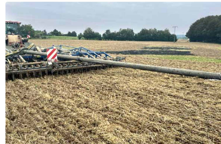
Ein Traktor fährt gegen einen Mittelspannungsmast bei Carlow. Hilfe ist schnell zur Stelle, sodass eine Stunde später bei allen betroffenen Kundinnen und Kunden der Strom wieder fließt.
