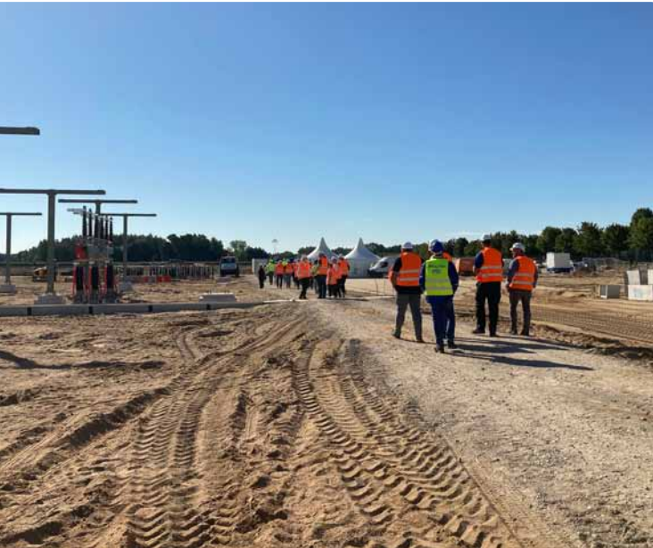
Baustelleneröffnung am Umspannwerk Vietlübbe/Kreien
