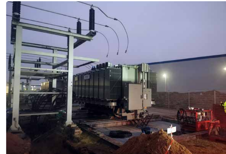
Um eine sichere und stabile Energieversorgung zu gewährleisten, investiert die WEMAG in den Ausbau und die Instandhaltung unseres Verteilnetzes. Hier zu sehen: Ein Trafo-Wechsel im Umspannwerk Zarrentin.
